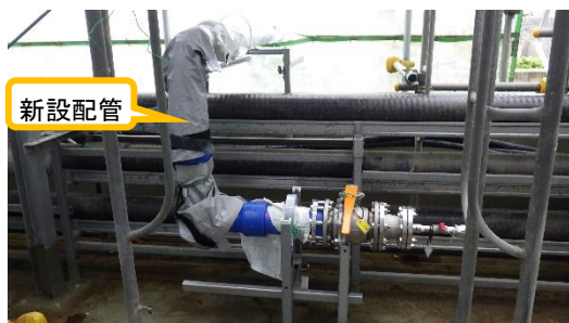
(写真1⑤) H1タンク内における 配管の設置状況 ※末端部
