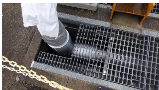
(写真2①) 移送配管の道路横断箇 所の設置状況
