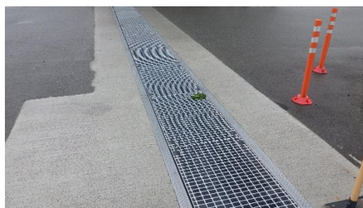
(写真2②) U字溝のグレーチング の状況
