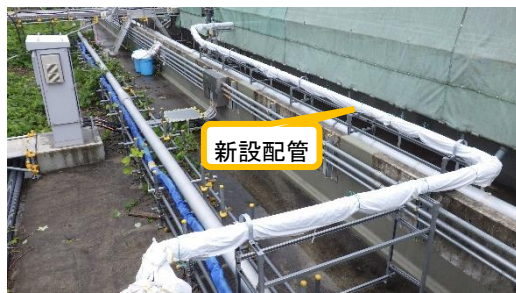
(写真 1 ④) H 1 タンク北側における配管の設置状況
