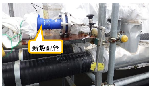
(写真1⑥) Dタンク南側における 配管の設置状況 ※末端部
