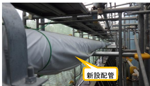
(写真 1 ②) H 8 タンク内における配管の設置状況
