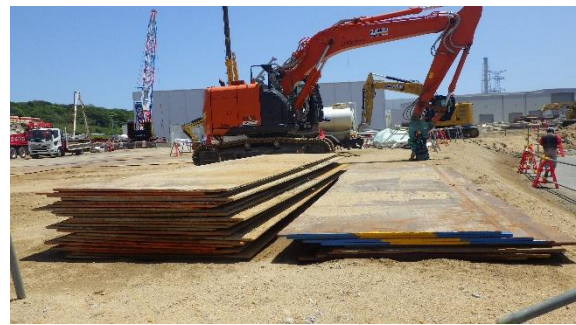
(写真4①) 鉄板の敷設
