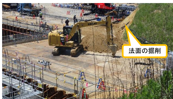
(写真4②) 法面の掘削
