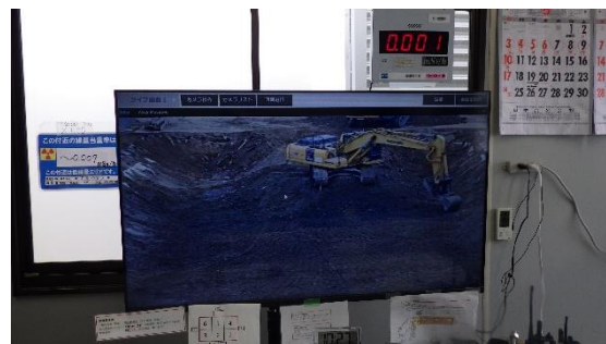
(写真2) 仮設ハウス内のモニタ ※ハウス内の作業を映したモニタ
