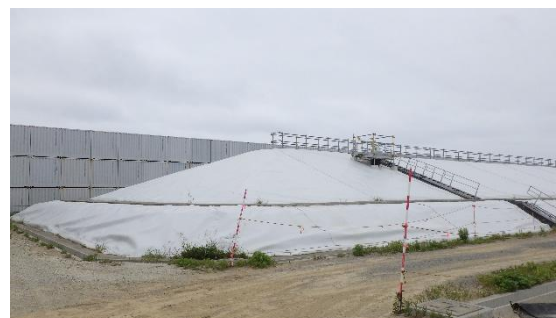
(写真4) 第3槽の状況
