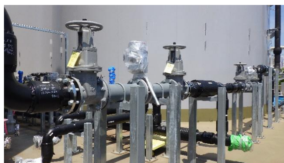
(写真1②) 配管及び弁の敷設状況
