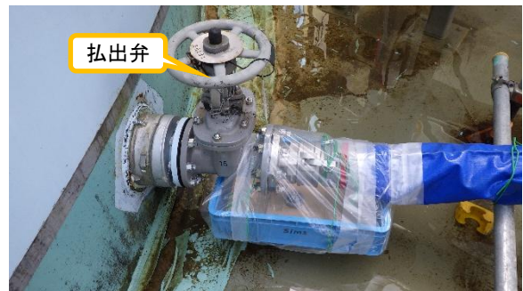
(写真6) 漏えい対策
