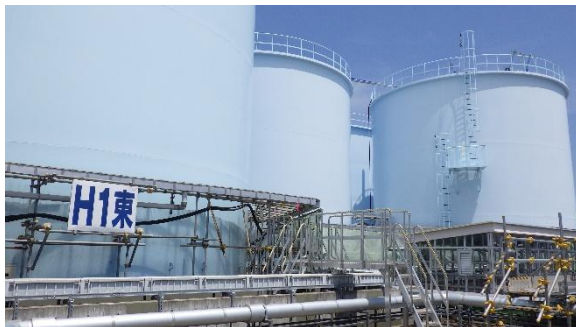
(写真4) H1東タンクエリア
