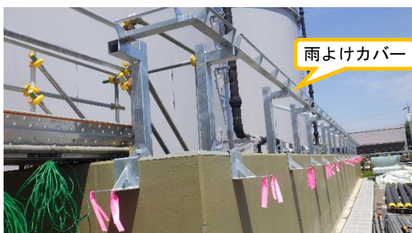
(写真2①) 雨よけカバーの骨組み
