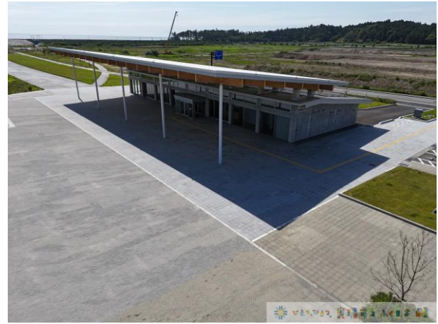
写真6 管理棟を南東方向に望む
