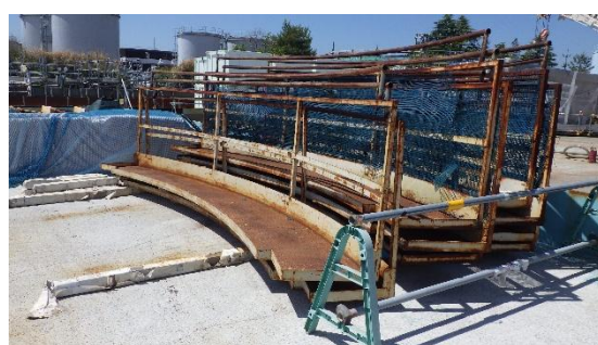
(写真 2－2) タンクヤード内の タンク解体部材の整理状況②
