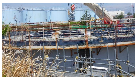
(写真 2－4) タンク第 1 段目上部の 蓋の設置状況②
