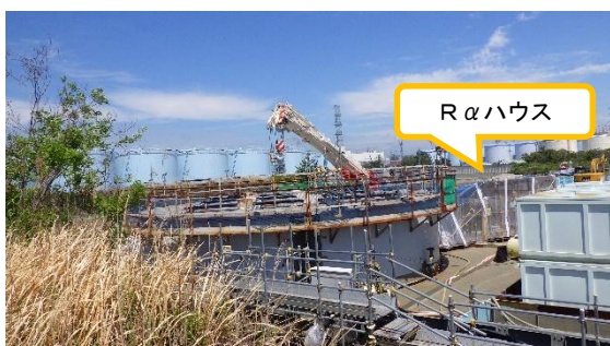
(写真 2－3) タンク第 1 段目上部の 蓋の設置状況①
