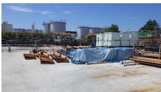
(写真 2－1) タンクヤード内の タンク解体部材の整理状況①
