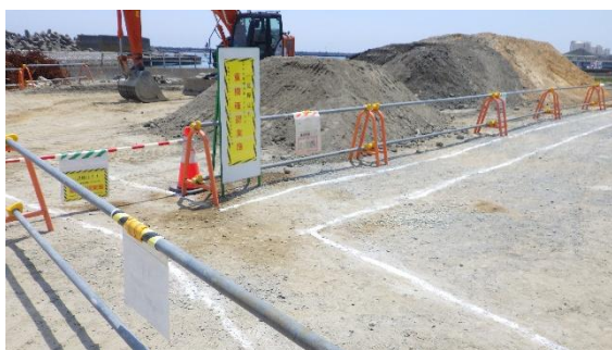
(写真2①) 土砂の仮置き
