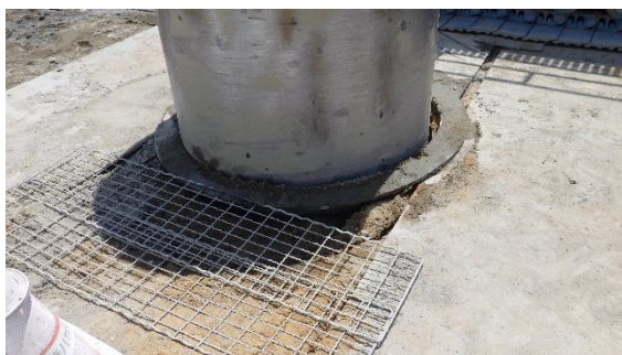
(写真1①) 掘削作業の状況
