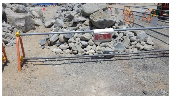
(写真2②) 瓦礫類の仮置き
