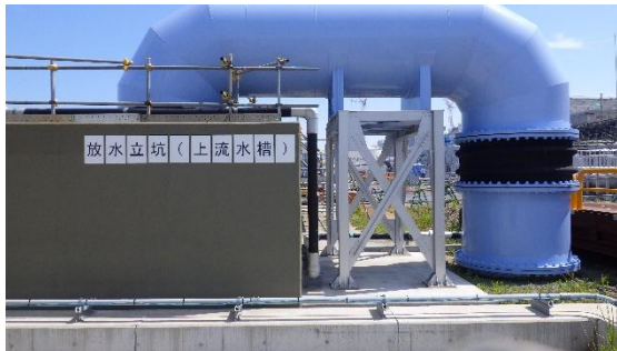
(写真3-2) 放水立坑(上流水槽)
