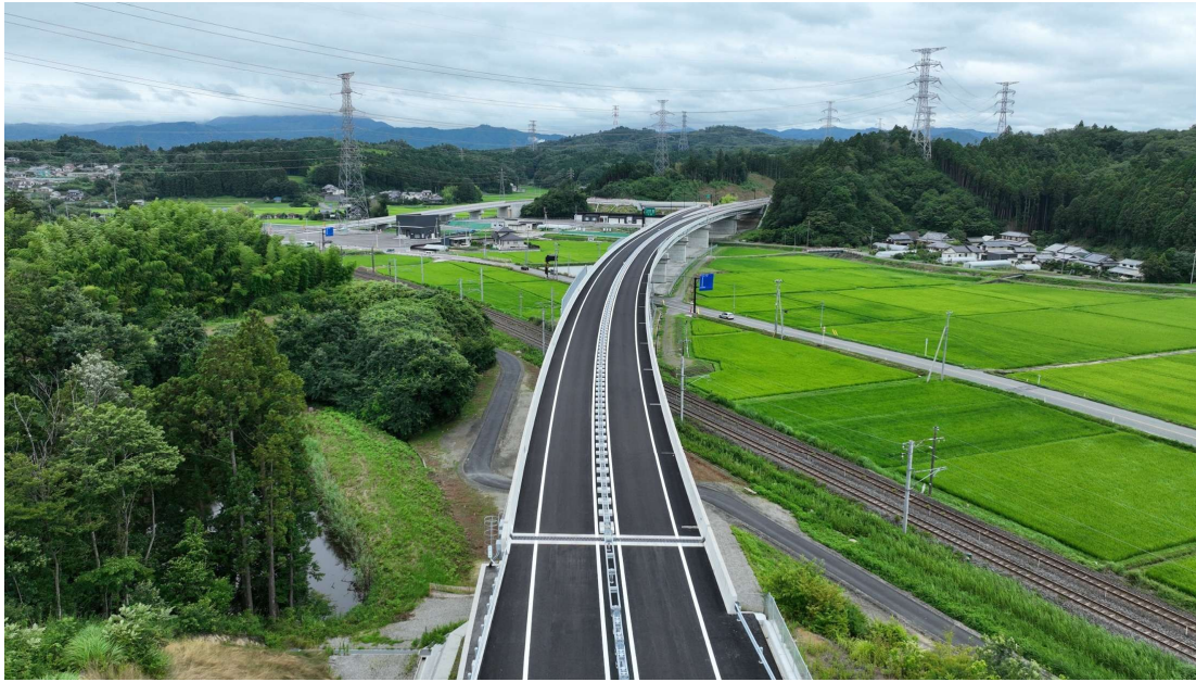
小名浜道路（いわき上三坂小野線）道路橋りょう整備工事（いわき市）
