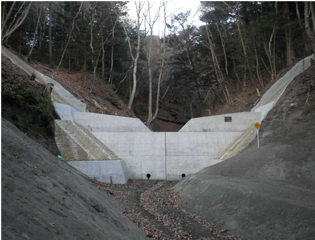
中島地区治山施設工事（飯館村）
