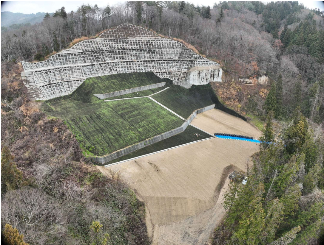
藤沢地区地すべり対策工事（喜多方市）
