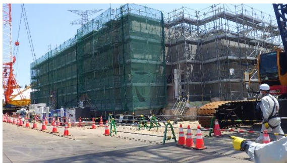
(写真1-1) 第2棟建設工事現場の外観
