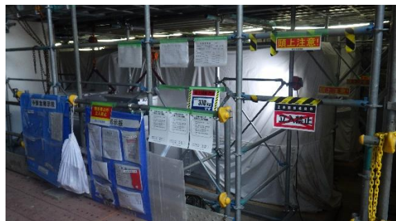
(写真2-2) 安全対策に関する掲示の状況
