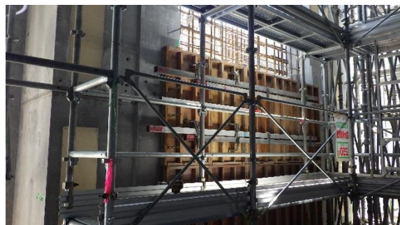
(写真1-2) 第2棟(地下階)の工事状況
