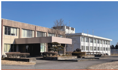
本館及び研究実験棟
