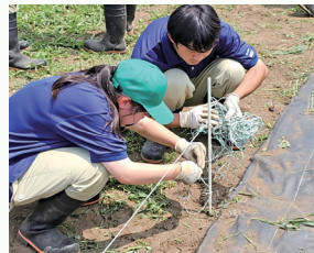
電気柵の設置
