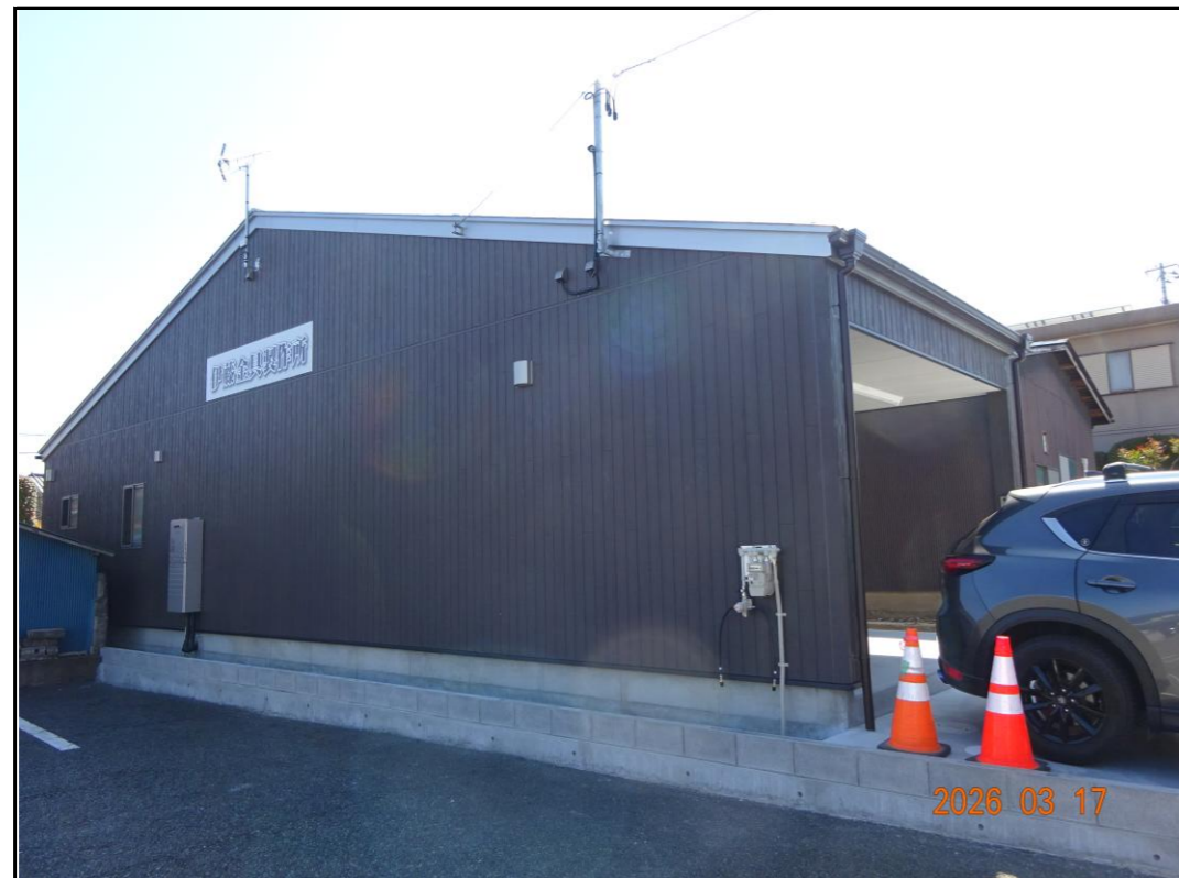
↑ 作業場外観①
