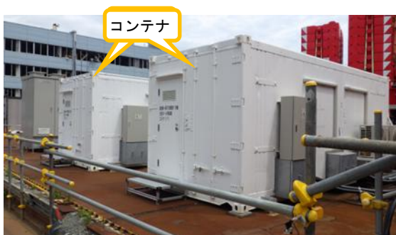
(写真1) ダスト放射線モニタ用の新設コンテナの外観
