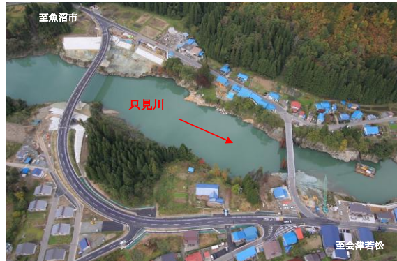
完成した二本木橋の新橋（上流側）と仮橋（下流側）
