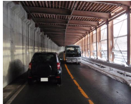
全面供用の状況
