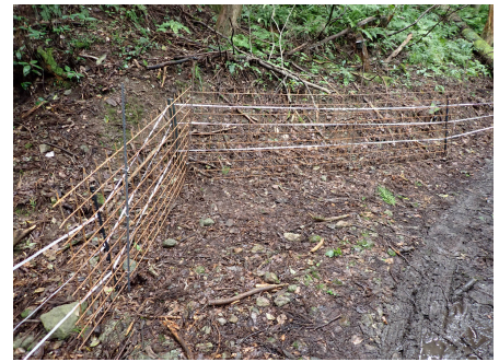
▲リボンワイヤーを設置したところ
