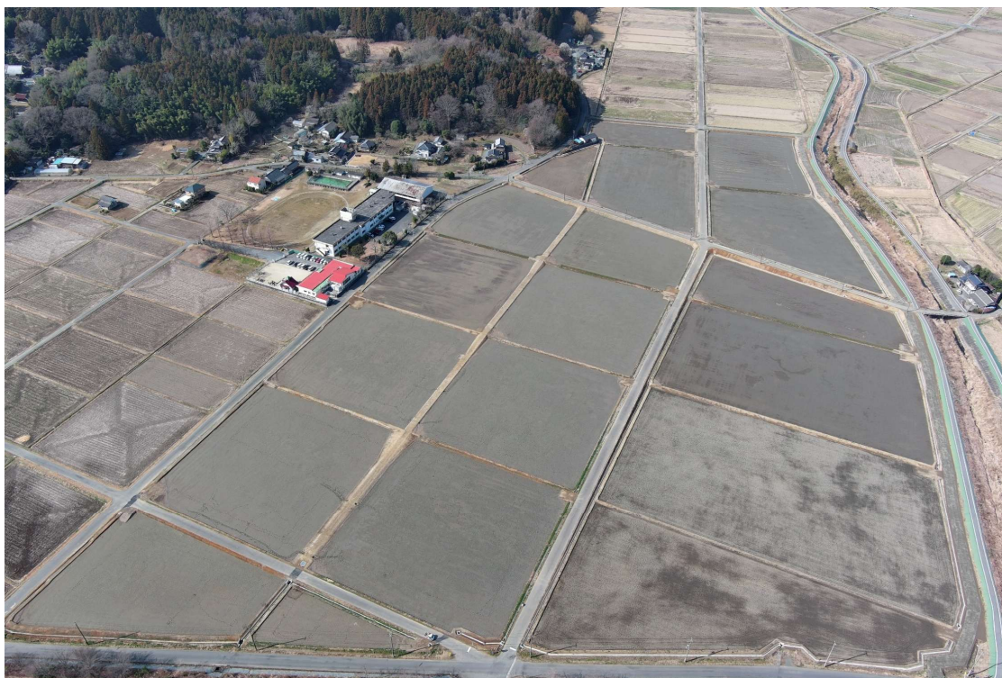
瀬戸地区農地中間管理機構関連工事（いわき市）
