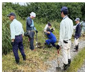
図3 恒久電気柵設置
