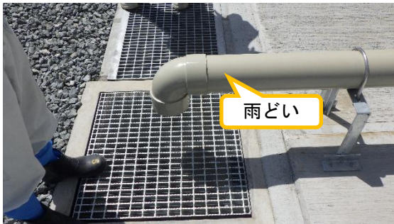
(写真 2—2) 外構工事の状況②
