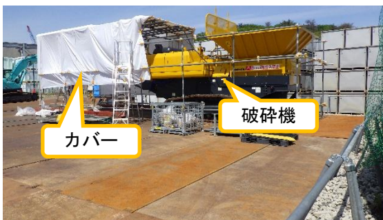
(写真 4) 破碎機及びカバーの設置状況
