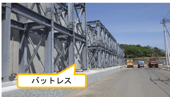
（写真1） バットレスの設置状況
