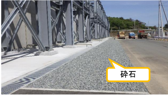
(写真 2—1) 外構工事の状況①
