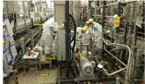
(写真 3) 処理水移送ポンプの 点検作業状況
