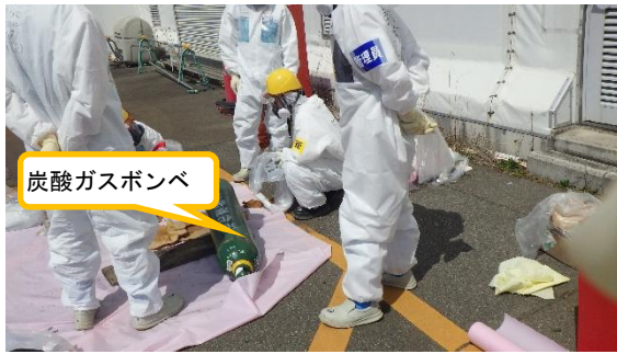
(写真 2) 建屋外における作業状況 炭酸ガスポンベの除染作業
