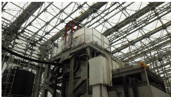
(写真 1①) 既設ALPSのメンテナンス作業の状況①
