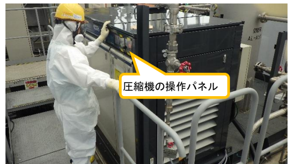
(写真 4 ②) 弁操作空気圧縮機の 点検作業状況②
