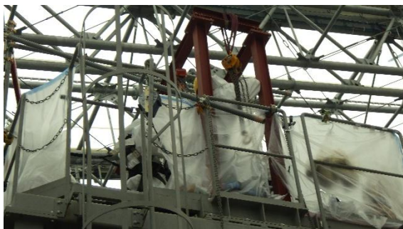
(写真 1③) 既設ALPSのメンテナンス作業の状況③
