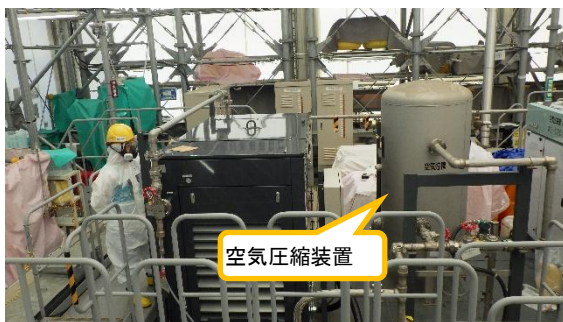
(写真 4 ①) 弁操作空気圧縮機の 点検作業状況①
