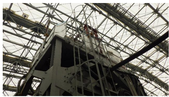
(写真 1②) 既設ALPSのメンテナンス作業の状況②
