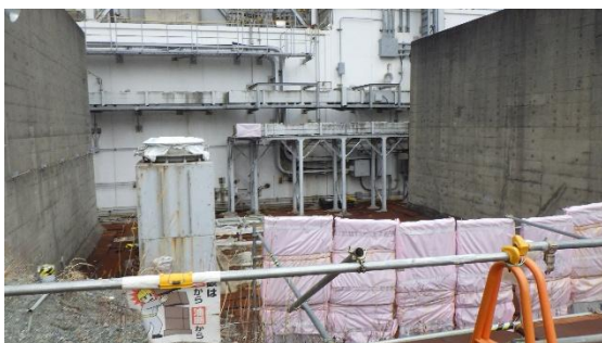
(写真4-2) 起動変圧器A設置跡の状況
