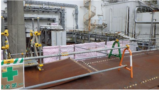
(写真4-3) 起動変圧器B設置跡の状況
