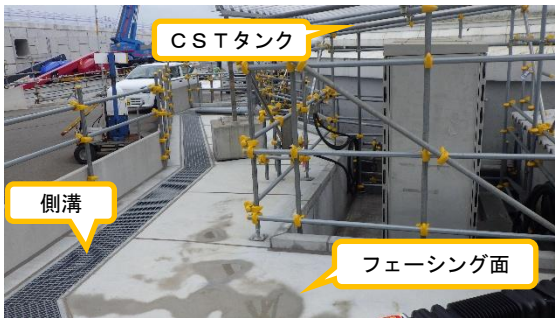
(写真1-2) 1号機CSTタンク周辺のフェーシング状況 ※1号機CSTタンク北側から撮影
