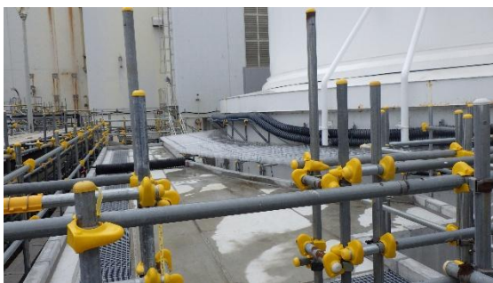
(写真1-4) 2号機CSTタンク周辺のフェーシング状況 ※2号機CSTタンク南東側から撮影
