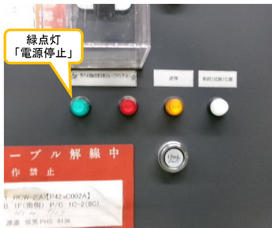
(写真2) 電源盤のRCW2ポンプ (A系) の監視制御箇所 (写真1拡大図)
