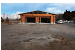
● 実習スペース
