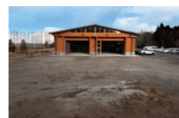
● 実習スペース
