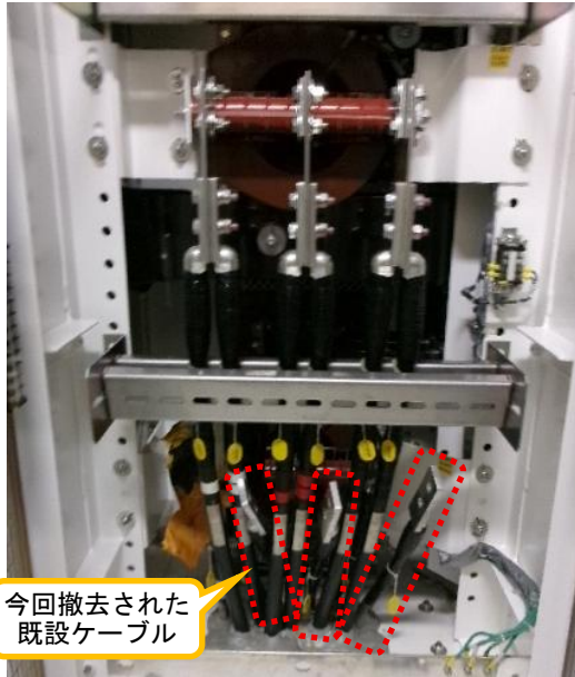
(写真1) 電源盤内部のケーブルの設置状況（今回撤去された既設ケーブルは、赤点線で囲んだ3か所、計6本）
