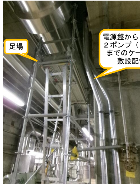
(写真2) 1号機海水熱交換器建屋地下における足場（ケーブル撤去用）の設置状況
