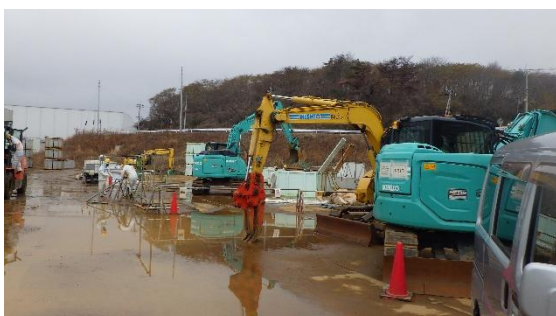
(写真5) 重機の配備状況
