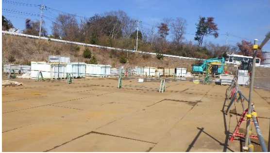
(写真6) 詰替ヤードの区画状況
