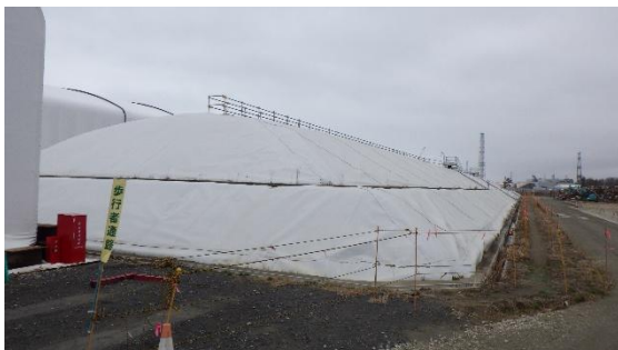
(写真4) 第2槽の状況
