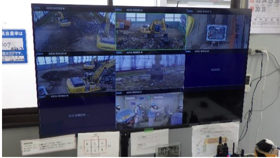
(写真1) 仮設ハウス内での作業状況 ※カメラ映像を映したモニタを 確認
