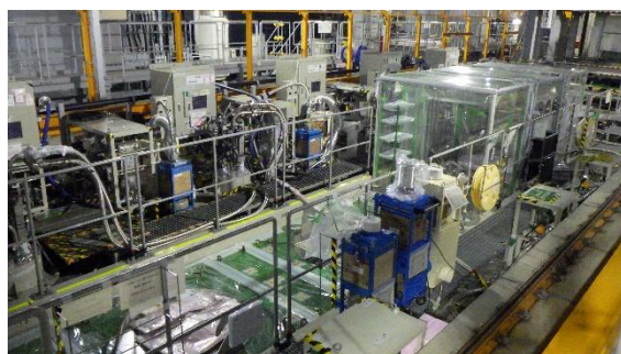
(写真5-1) 増設ALPS建屋内のメンテナンス作業①
