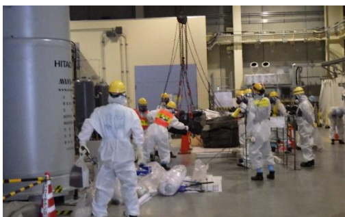
(写真 2 - 2) 前処理フィルタ開放点検の状況②
