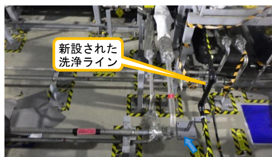
(写真3-2) 循環洗浄用新設配管の設置状況②
