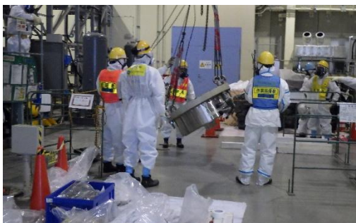
(写真 2 - 1) 前処理フィルタ開放点検の状況① (前処理フィルタ 3 B天頂部の天地 換え)
