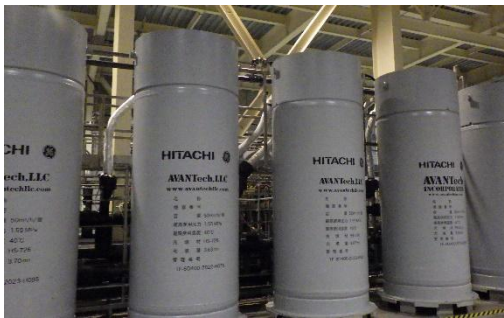
(写真 1 - 4) 吸着塔の設置状況 (5基)
