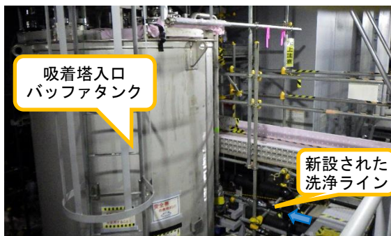
(写真4-1) 吸着塔入口バッファタンクへの配管（洗浄ライン）の接続状況
