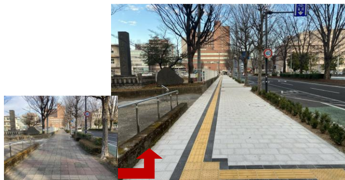
◆県道水原福島線(杉妻工区) <整備中>
