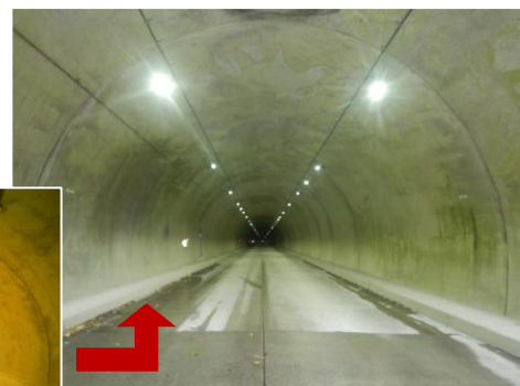
◆国道459号（宮古トンネル）<完成後>
