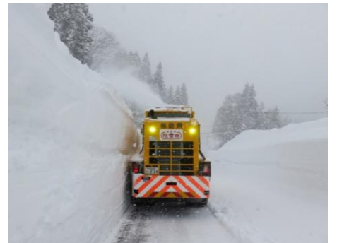
◆柳津昭和線(柳津町) <除雪状況>
