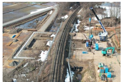
◆町道磐梯大谷線(大谷工区) <整備中>
