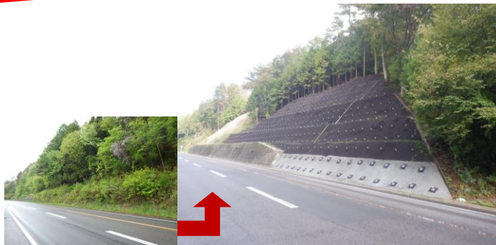
◆国道288号(芹ヶ沢工区) <完成後>
