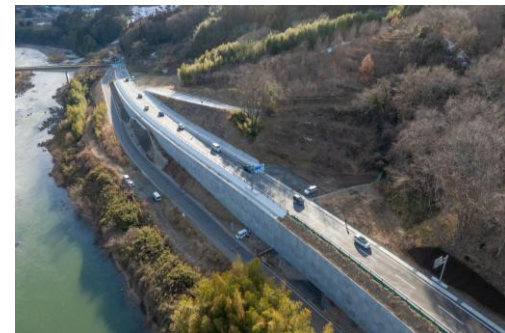
◆国道349号（五十沢1工区）<完了後> 令和8年1月31日開通
