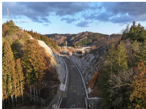
① 県道いわき石川線（石川BP）＜整備中＞
