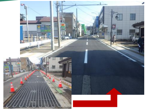
◆国道252号(七日町工区) <消雪・一部完>
