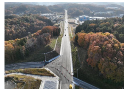
◆国道288号の整備状況
