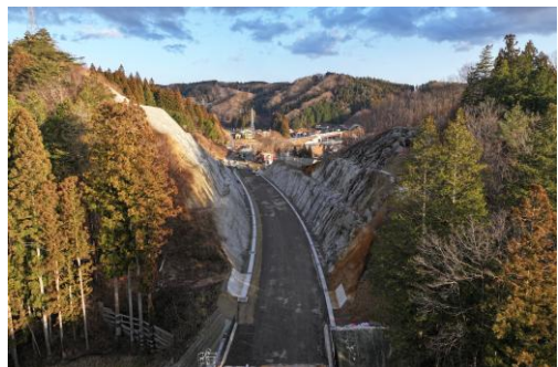
◆県道いわき石川線（石川BP1工区）<整備中>
