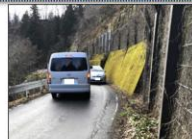
車両のすれ違いが困難な箇所 (会津若松三島線 三島町)
