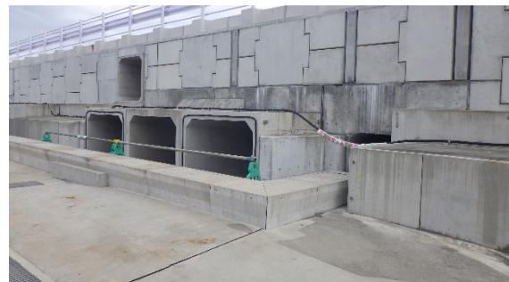
(写真 2 ②) フラップゲートの状況 (陸側)
