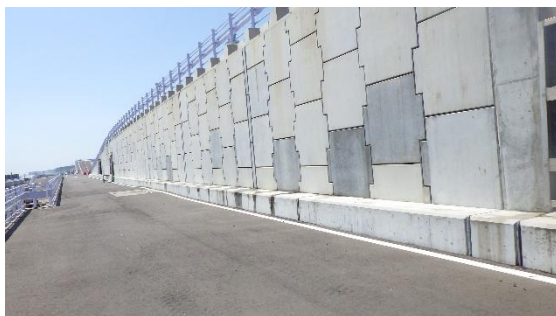
(写真 1 ③) 防潮堤海側通路の状況
