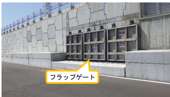
(写真 2 ①) フラップゲートの状況 (海側)
