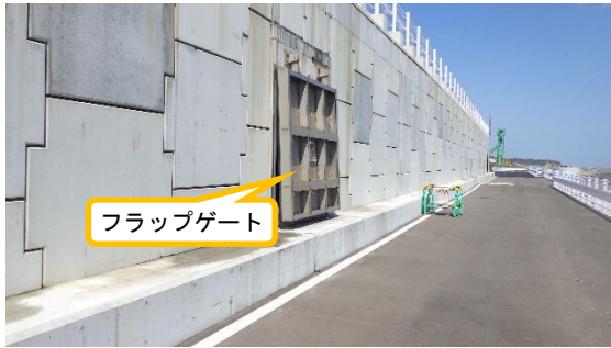
(写真 1 ①) 防潮堤の状況 (海側)
