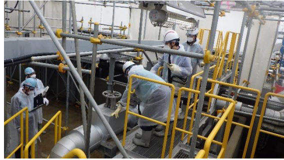
(写真1②)払出弁の全開作業
