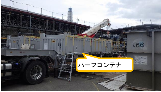
(写真4①) 詰替え輸送用ハーフコンテナと重機の 配置状況
