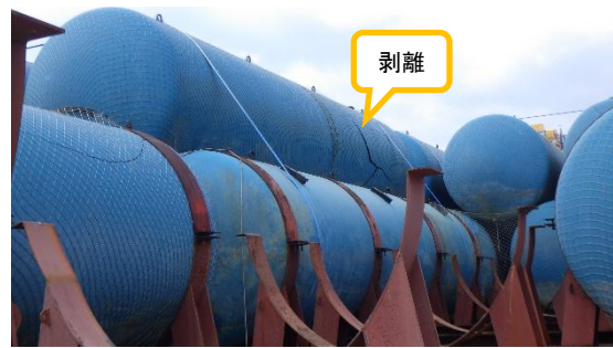
(写真6) ブルータンクの状況
