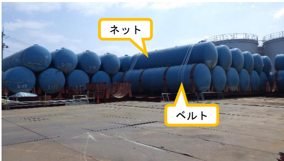
(写真5) ブルータンクの保管状況
