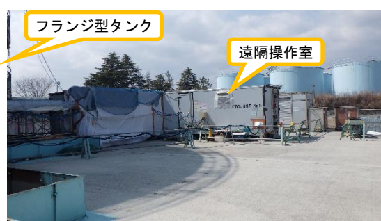
（写真2）遠隔操作室の設置状況
