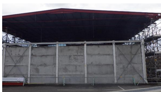
(写真 4-2) 西側の遮へい壁と周囲の状況
