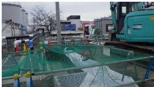
(写真1) 掘削の状況 (J7タンクエリア)
