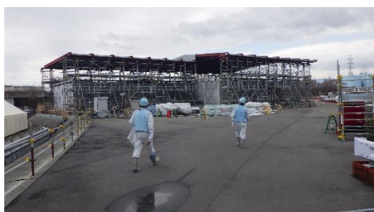
(写真 4-1) H2タンクエリア鋼製横置きタンクの設置状況
