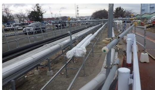
(写真 3) H1タンクエリア西側における配管敷設の状況
