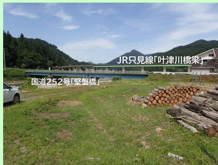
▲雪の案内標示実施箇所 (国道252号沿線)
