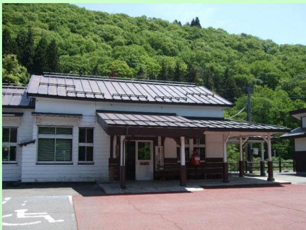
会津柳津駅 (改修前)
