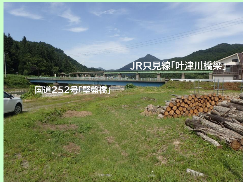
▲雪の案内標示実施箇所 (国道252号沿線)
