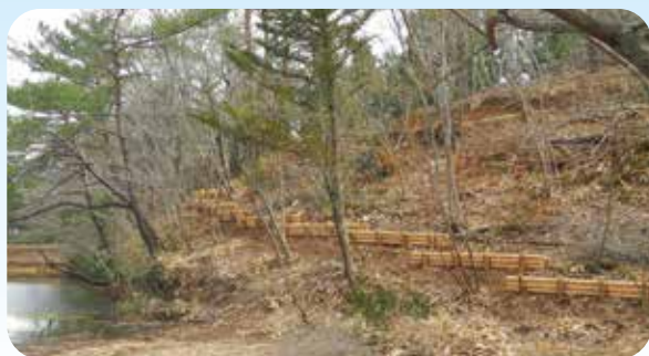
丸太を活用した土壌流出防止柵の設置
