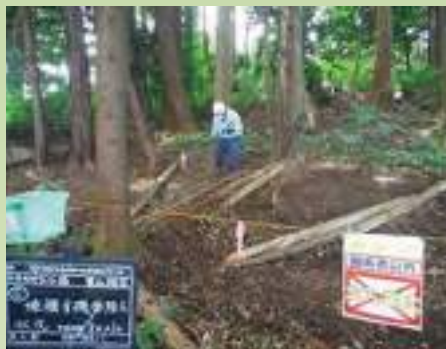
例：残渣除去の様子
