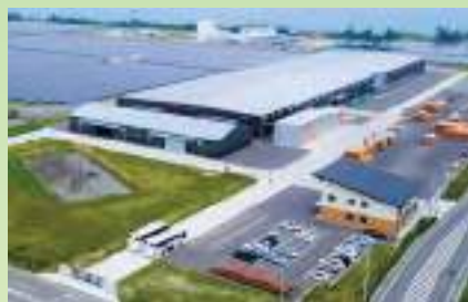
●福島高度集成材製造センター（FLAM）全景
