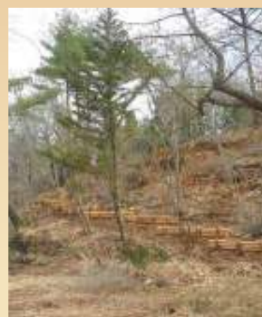
丸太を活用した土壌流出防止柵の設置
