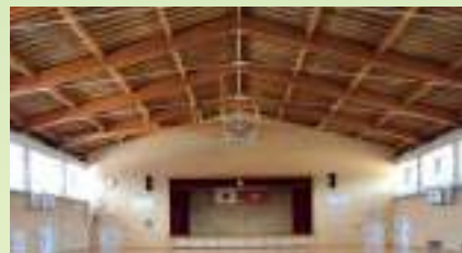
●福島市立渡利中学校屋内運動場
