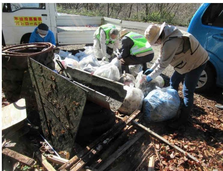
建設系廃棄物等の撤去
