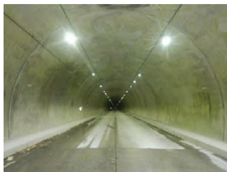
国道459号宮古トンネル（喜多方市）
