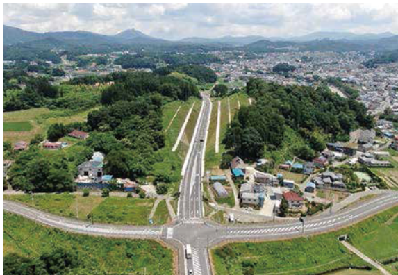
国道288号 船引バイパス（田村市）
