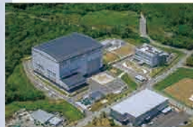
楢葉遠隔技術開発センター
