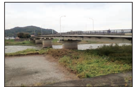
耐震補強予定の橋梁 (国道115号 福島市)
