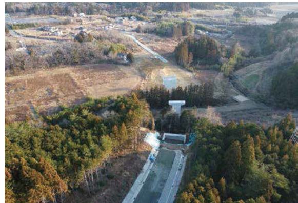
小野富岡線 高津戸工区（富岡町）
