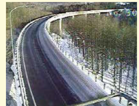
国道115号 土湯峠 (横向大橋)
