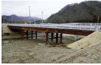
H23.11.11 応急復旧完了 (通行止め解除)
