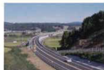
福島空港道路
