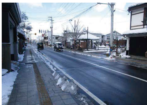
無散水消雪施設 国道252号 七日町工区 (下の区)(会津若松市)
