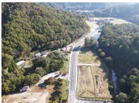
基幹的な道路 （小野富岡線 西ノ内工区【川内村】）
