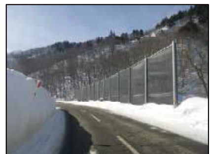
雪崩対策施設設置 (国道352号 南会津町)
