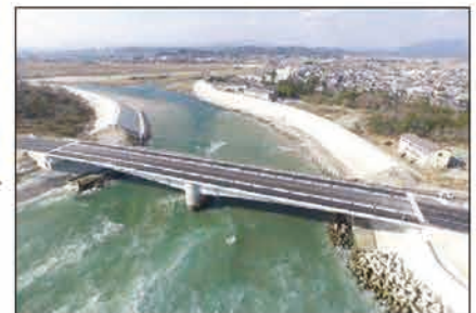
豊間四倉線 東舞子橋工区（いわき市）
