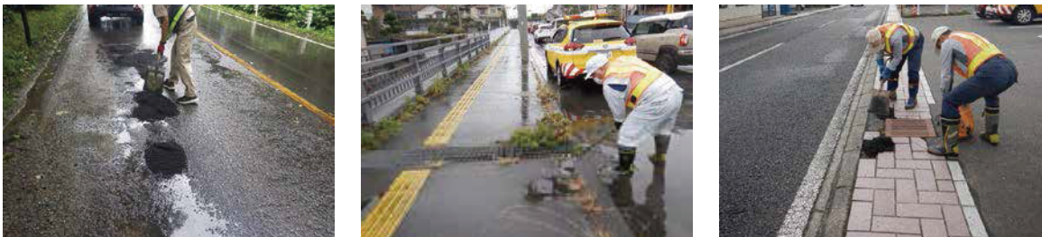
道路パトロールによる路面補修など
