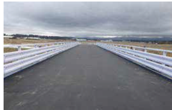
H31.3.29 仮橋供用開始
