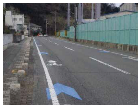
自転車走行空間の整備 (いわき七浜海道 いわき市)
