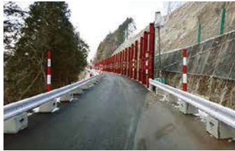
H23.12.22 応急復旧完了 (通行止め解除)
