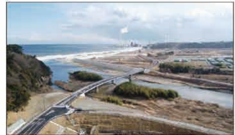
広野小高線 天神工区（楢葉町）
