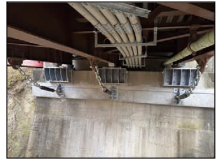
対策実施済の橋梁 (国道121号 下郷町)
