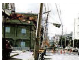
阪神淡路大震災で倒壊した電柱（出典：国土交通省）
