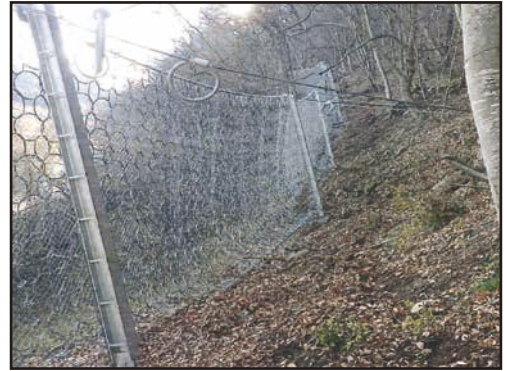
落石防護柵施工箇所 （国道121号 八千窪工区 西会津町）
