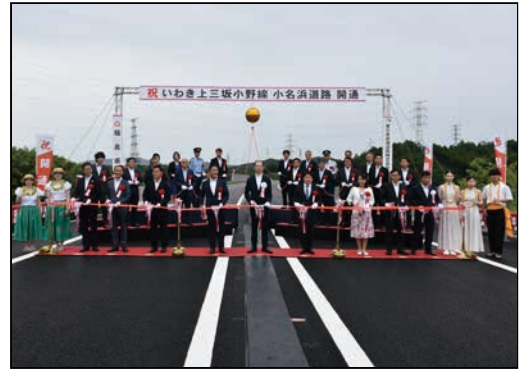
開通式（いわき上三坂小野線小名浜道路 いわき市）
