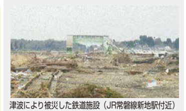
津波により被災した鉄道施設（JR常磐線新地駅付近）
