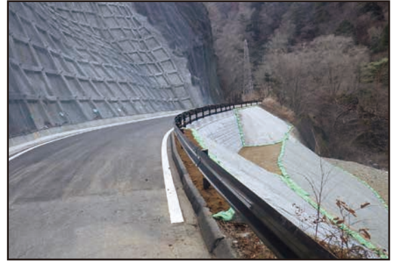
法面对策施工箇所 （落合浪江線 小丸工区 浪江町）
