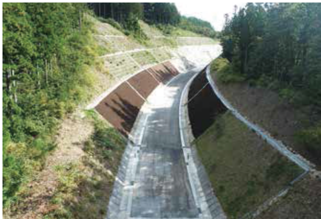
地域連携道路 (国道349号 檜坂工区)
