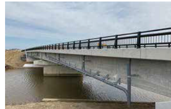
R2.12.25 新橋供用
