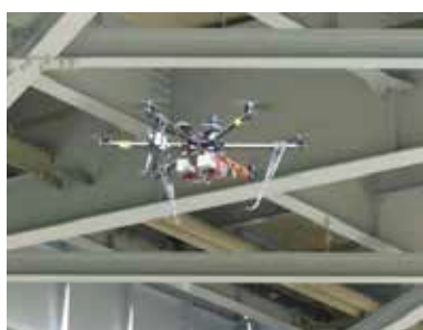
ドローンによる橋梁点検
