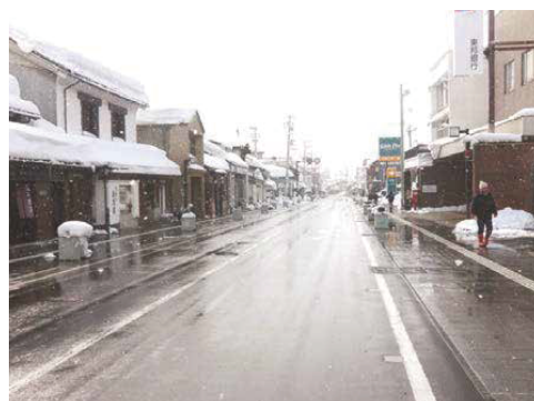
無散水消雪施設 喜多方会津坂下線 三丁目工区 (喜多方市)
