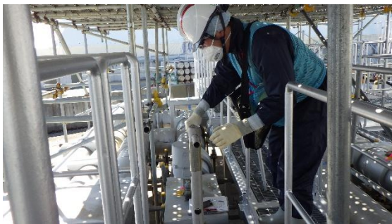
(写真2) 排水弁の全開作業
