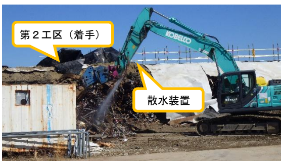
(写真 5) 第2工区における作業状況 ※重機に取り付けられたノズルから散水しながら瓦礫類の把持、積み込みが行われている。
