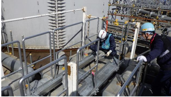
(写真 1 ①) ライン構成の状況
