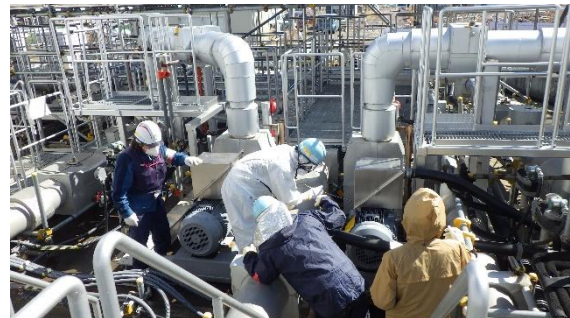
(写真 3) ポンプ起動後の確認
