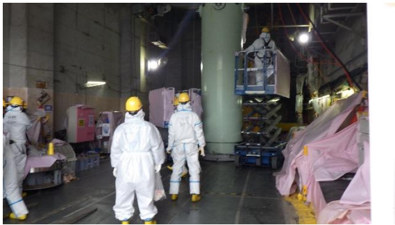
(写真 3-1) サイトバンカ建屋大物搬入口におけ る除染作業状況①
