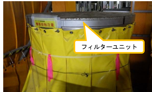
(写真3) フィルターユニットの設置状況
