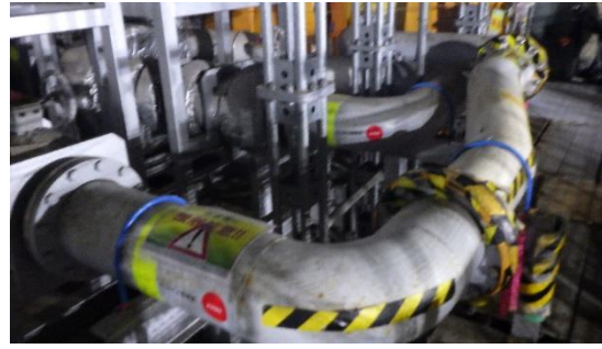
(写真 4 ②) 配管の敷設状況②
