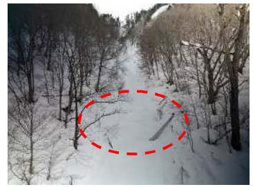
国道352号(南会津町)【雪崩】
