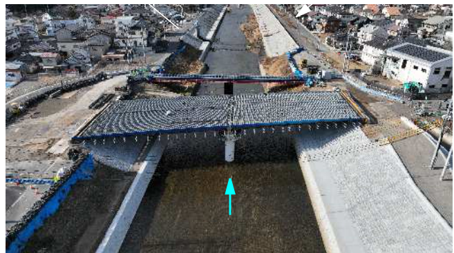
逢瀬川 河川改修事業（整備状況）
