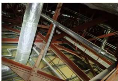
あづま総合運動公園(福島市) 【減災化事業】 あづま総合体育館メインアリーナにおいて、天井吊り部材更新を実施
