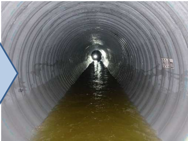
管更生により耐震性能を確保
