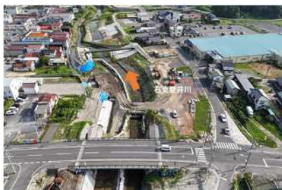
右支夏井川(小野町)【河川整備事業】 築堤護岸工を実施 等
