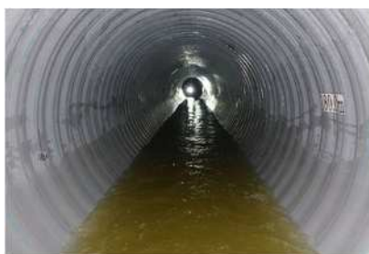
県中幹線(郡山市)【改築事業】 老朽化した下水道管路について、管更生工法による改築を実施 左岸幹線(福島市)【耐震化事業】 耐震化されていない下水道管路について、管更生工法による耐震化を実施
