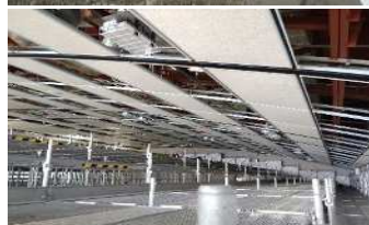
体育館(天井)の耐震改修
