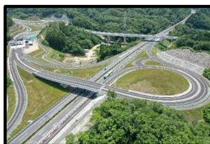
小名浜道路(いわき市)
