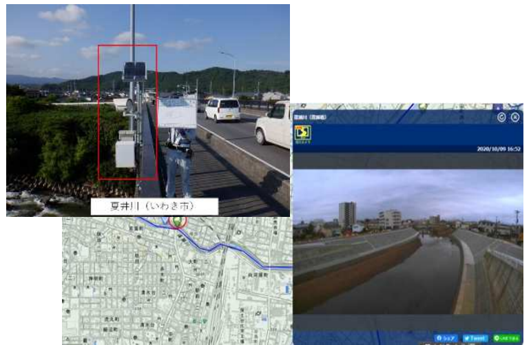
簡易型河川監視カメラ型の設置
