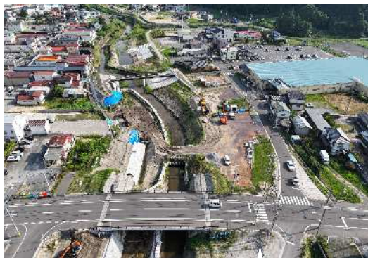
右支夏井川 河川改修事業（整備状況）
