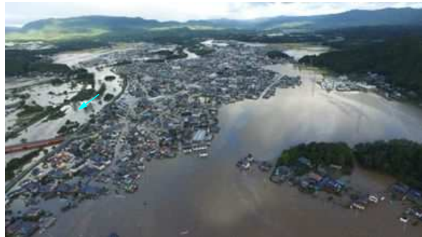
夏井川（いわき市）の施工状況
