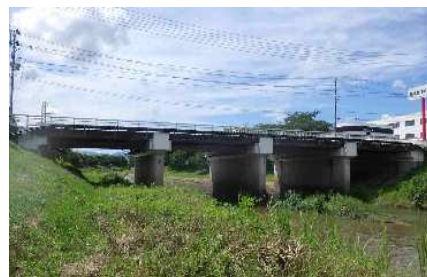
郡山停車場線 永盛橋(郡山市) 【橋梁補修事業】 橋梁点検結果を踏まえ、伸縮装置及び高欄補修等を実施する。
