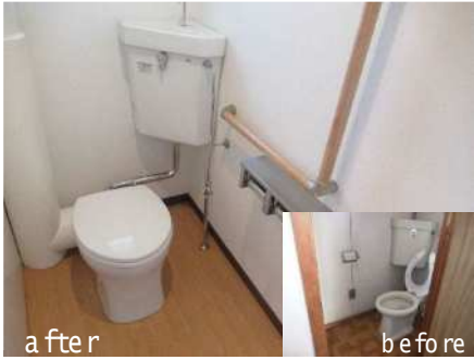
①トイレの段差解消・便器更新・手すり設置
