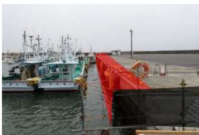
請戸漁港(浪江町)【漁港事業】 岸壁改良工を実施
