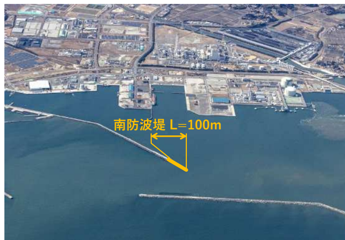
相馬港防波堤整備箇所
