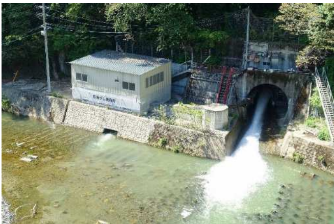
四時ダム発電所(全景)
