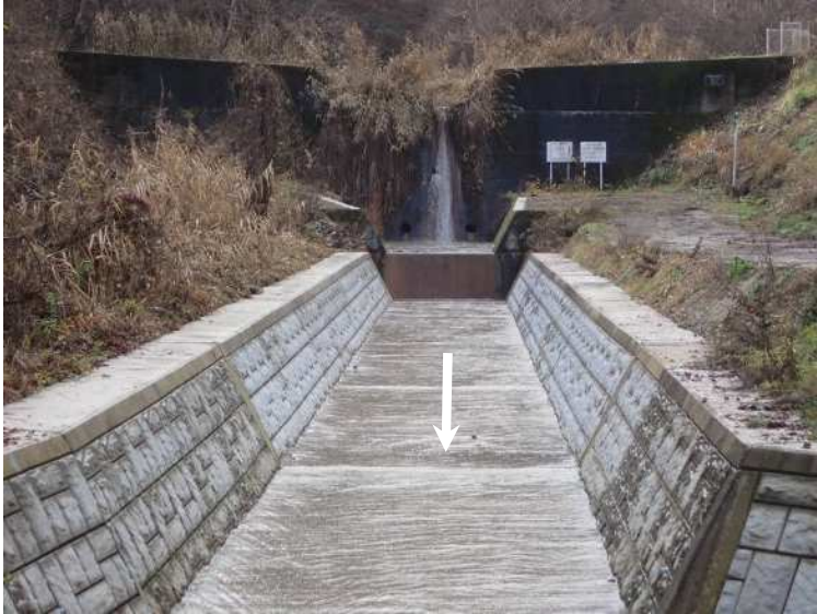
溪流保全工完了後
