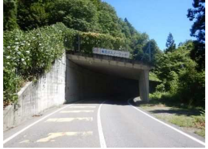
2 国道252号 高清水スノーシート(三島町)【構造物修繕】
