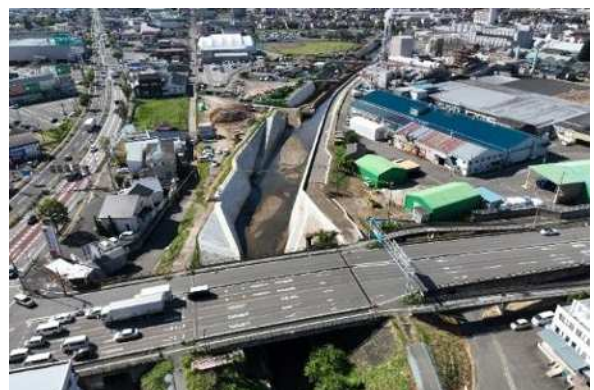
濁川 河川改修事業（整備状況）
