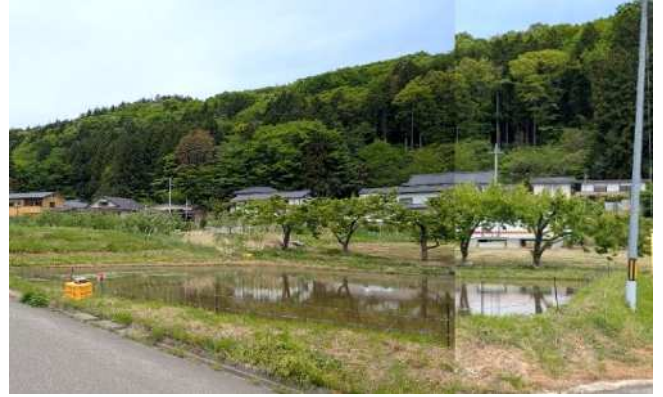
8 安養寺(福島市)【擁壁工】
