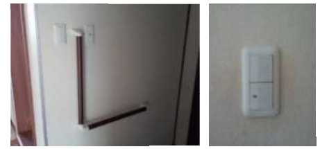
④玄関へ手すり設置 共通(スイッチのワレバ化)
