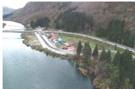
現況（湯倉地区）
