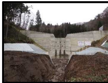
西田面沢 砂防事業(会津若松市)
