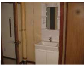
③洗面所へキャビネット型洗面化粧台設置(シングルバ-混合水栓付き)
