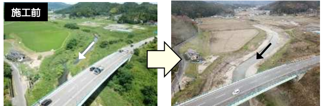
(河道掘削) 大久川(いわき市)
