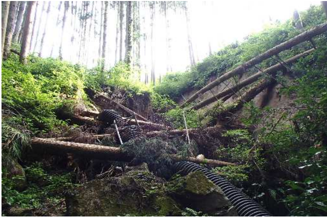
7 大室沢(石川町)【堰堤工】
