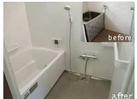
②浴室へユニットバス(シャワー付き混合水栓付き)・手すり設置
