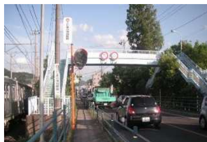
(都)栄町大笹生線(福島市) 【防災・安全交付金事業】 県道 福島飯坂線において、現道拡幅を実施
