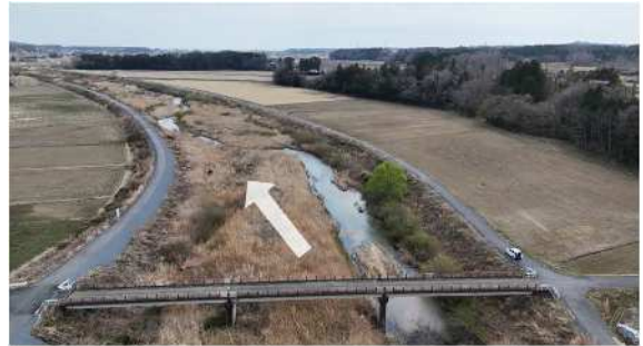
請戸川 (浪江町: 馬場内橋より下流)
