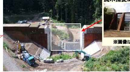
流木捕捉工を設置
