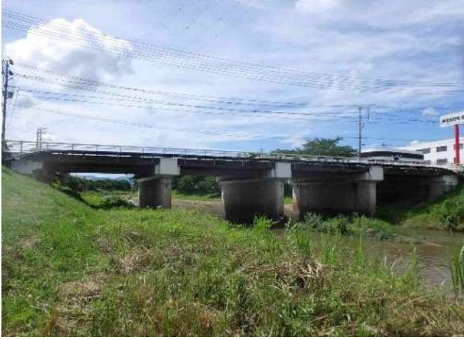
1 郡山停車場線 永盛橋(郡山市)【橋梁修繕】
