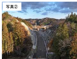
整備状況 (一ノ沢地内)
