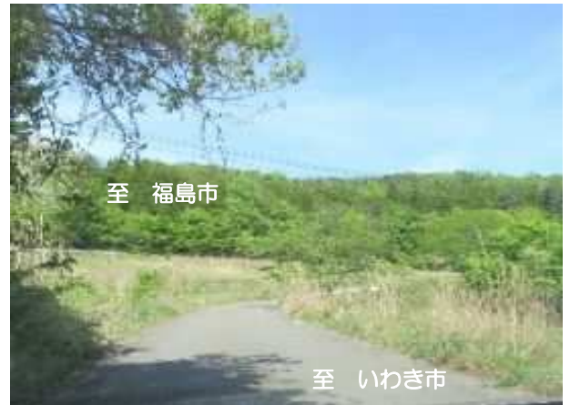
4 国道399号 滝下工区(飯舘村)【道路改良】
