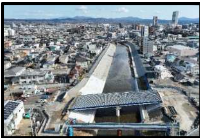
逢瀬川 河川改修(郡山市)
