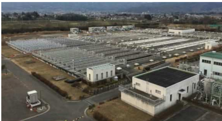
県北浄化センター
