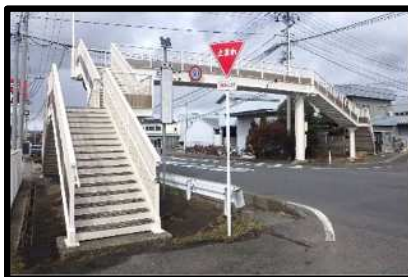
国道288号 原歩道橋(郡山市)
