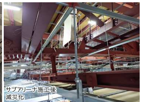
サブアリーナ施工後
