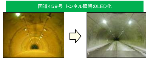
<トンネル照明の灯具をLEDに更新しCO2を削減>
