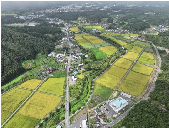
復興基盤総合整備事業(田村市常磐町西向地内)
