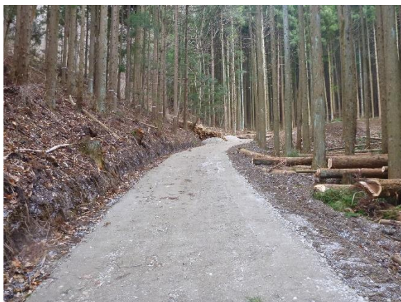
森林作業道の開設
