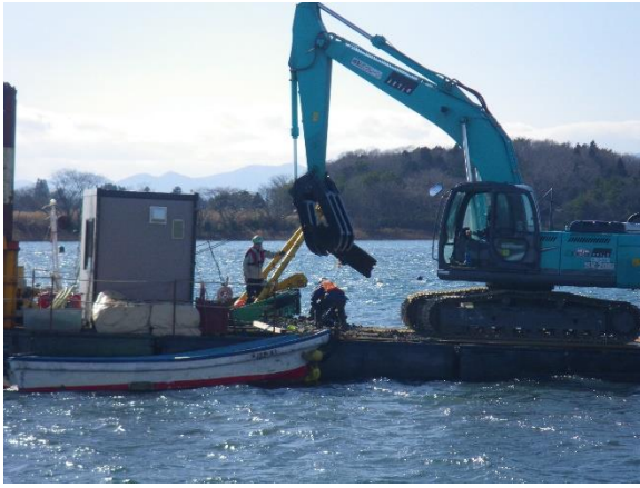
起重機船による漁場内に残存したがれき等の除去作業
