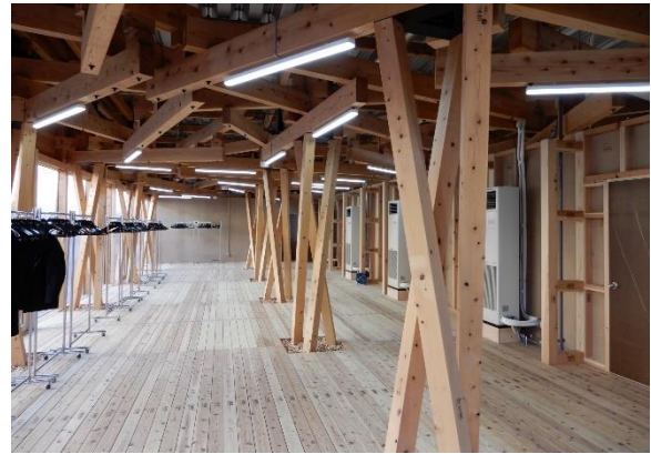
認証材を使用した施設(東京オリンピック・パラリンピック選手村ビレッジプラザ)
