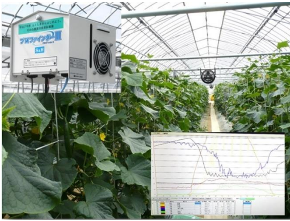
園芸施設の環境測定装置
