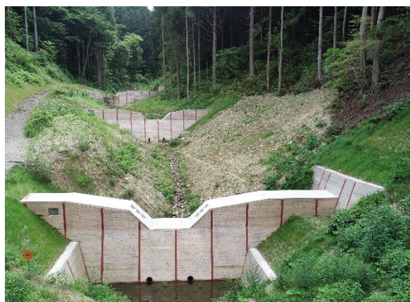
復旧治山事業による治山施設の整備
