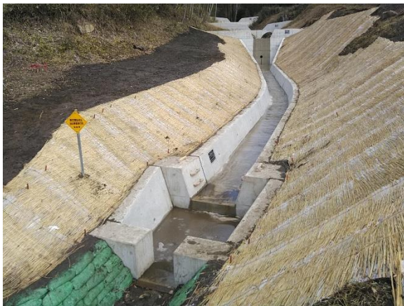
治山事業による防災・減災対策 治山施設(川俣町)
