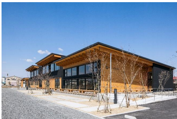
中大規模建築における県産材の利用 (郡山ヘアメイクカレッジ)
