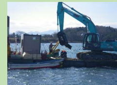
漁場内のがれき等の 除去作業
