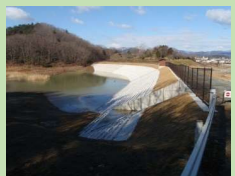
老朽化したため池の改修
