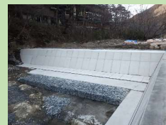
老朽化した 頭首工の補修
