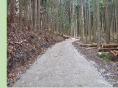
森林作業道の開設
