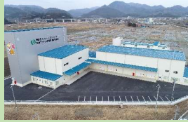
営農再開に向けた施設整備
