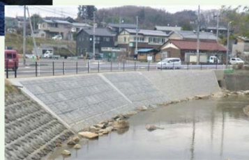
▼ 復旧後 (令和2年3月)
