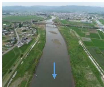
▼ 復旧後(災害復旧助成事業) (令和6年8月)
