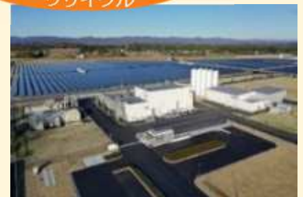
福島水素エネルギー研究フィールド
