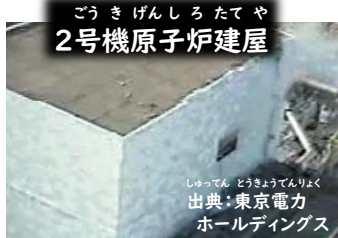
2号機原子炉建屋 1号機の爆発の衝撃で開いたパネルから水素が外に排出されたため、爆発しなかった。
