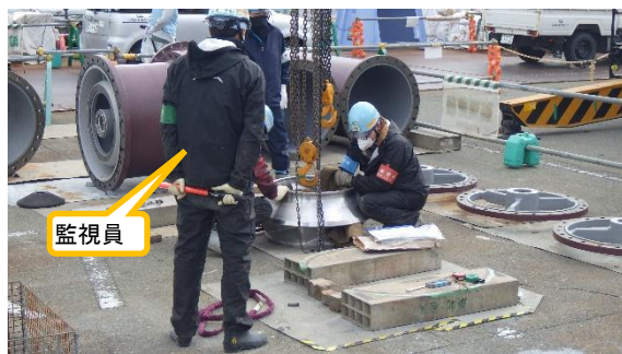
(写真2①)海水移送ポンプ A 系の組立作業の状況
