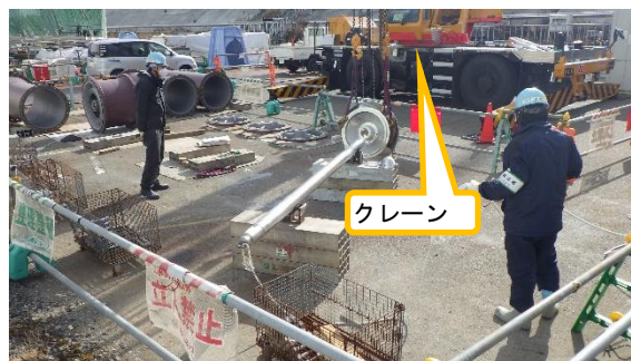
(写真2②)海水移送ポンプ A 系の組立作業の状況
