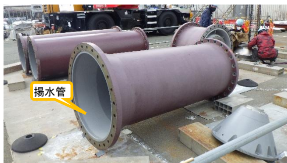
(写真1①) 海水移送ポンプ A 系の部品 (揚水管等)
