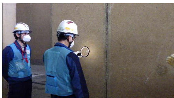
(写真4①)放水立坑(上流水槽)の点検作業(壁面調査)の状況
