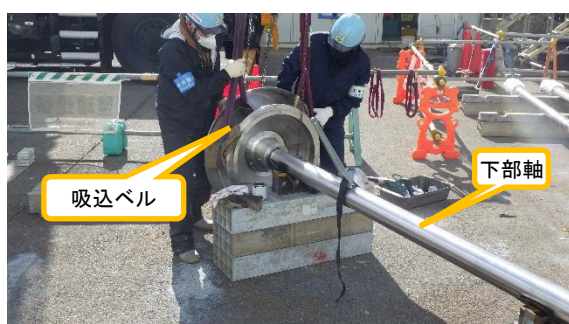
(写真2③)海水移送ポンプ A 系の組立作業の状況
