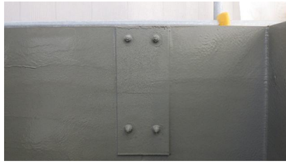
(写真 5 ②) 接続部の補強状況
