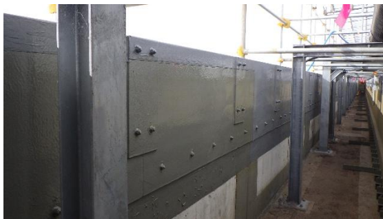
(写真 5 ①) 外堰の嵩上げ状況
