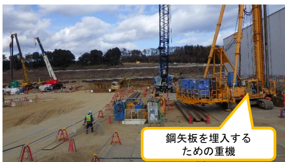
(写真 4 - 1) 鋼矢板の埋入作業の状況① ※東側の状況
