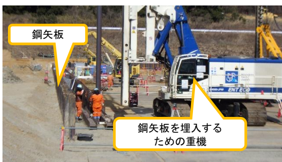
(写真 4 - 2) 鋼矢板の埋入作業の状況② ※西側の状況
