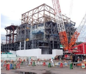
1号機の大型カバー設置の様子
